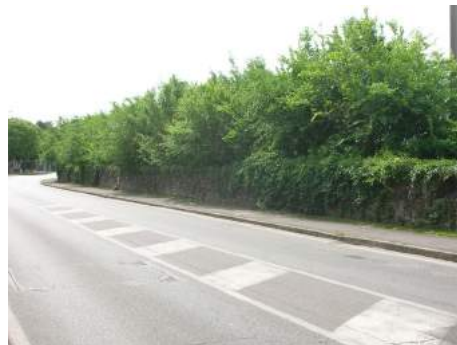
6 da Via Torricella di Sopra
