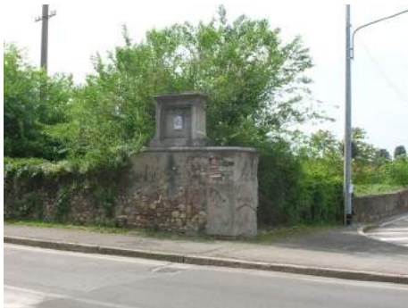
5 da Via Torricella di Sopra
